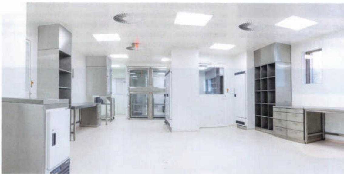
Fertiger und qualifizierter Reinraum – Die Produktion kann beginnen. Alle Wand-, Boden- und Deckenflächen sind leicht reinig- und desinfizierbar und haben glatte Oberflächen. Materialschleusen und Reinraummöbel sind aus hochwertigem Edelstahl gefertigt. (Abb. © Becker Reinraumtechnik)
